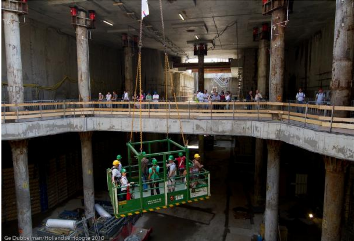
Belangstellenden dalen af in de bouwput Voorplein CS tijdens de Open Dag Noord/Zuidlijn
