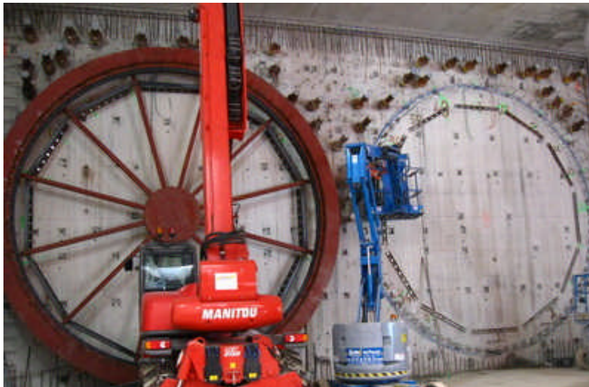
De eerste stalen ring van de brilwand wordt geplaatst in de startschacht in het Natte Damrak. [juli]
