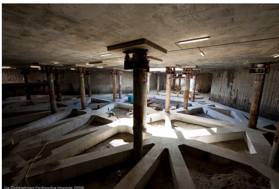
Ge Dubbelman/Hollandse Hoogte 2009 Het betonnen stempelraam onder het voorplein
