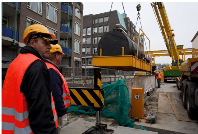
Inhijzen van de vriesinstallatie aan de Vijzelgracht
