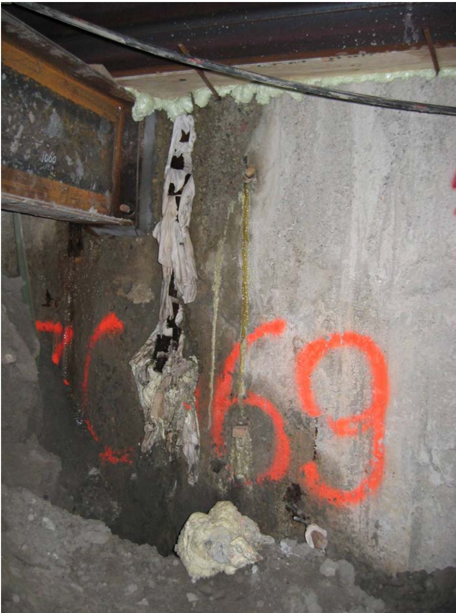
(voeg 69/70 station Vijzelgracht)
