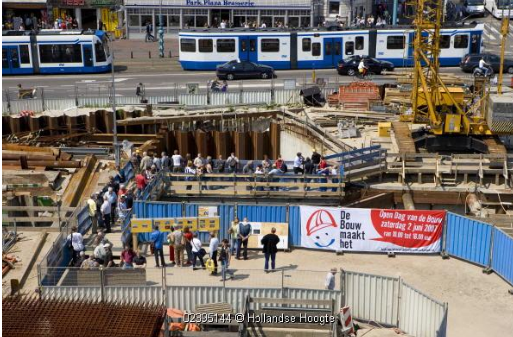
De startschacht tegenover het Hotel Victoria was tijdens de Open Dag een veelbezochte bouwplaats.
