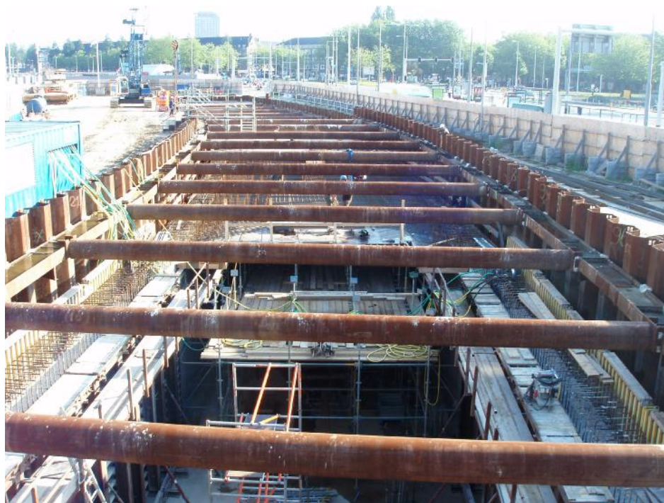
De bouwkuip voor de tunnel langs de Europaboulevard. De tunnel buigt hier in de richting van het Scheldeplein. Dit plein is het eindpunt van de tunnelboormachines.
