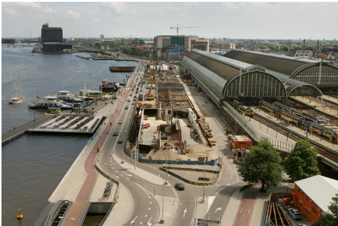
Overzichtsfoto van IJsei van juni. Op de voorgrond is de inrit van de auto-onderdoorgang al goed zichtbaar.
