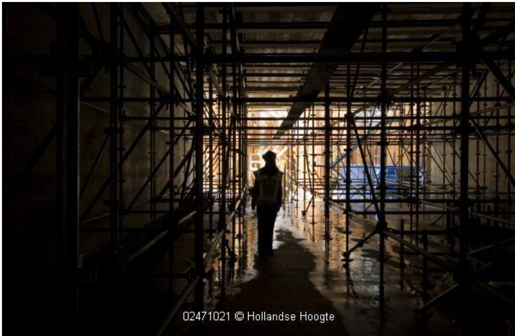
Een sfeerbeeld in de bouwkuip op het Europaplein
