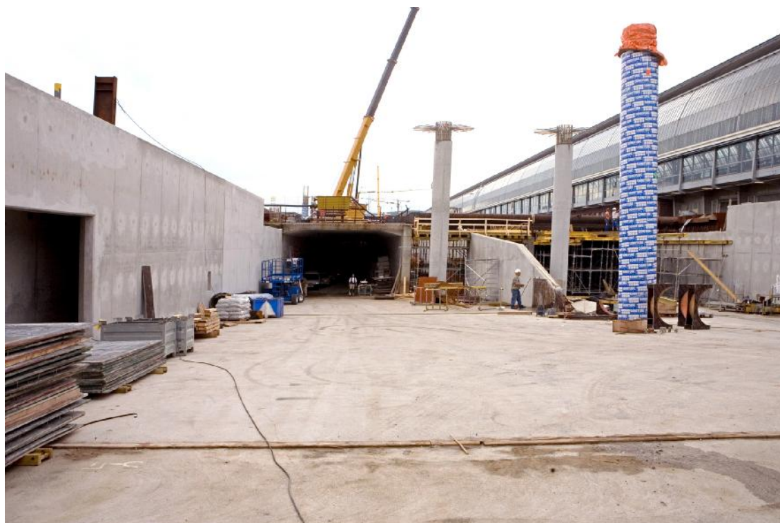
De inrit van de auto-onderdoorgang in aanbouw. Op de voorgrond staan de kolommen van de oprit naar het busstation.
