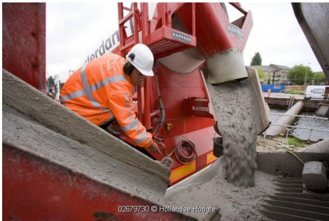
Betonstort voor de vloer van de tunnel langs de Europaboulevard.
