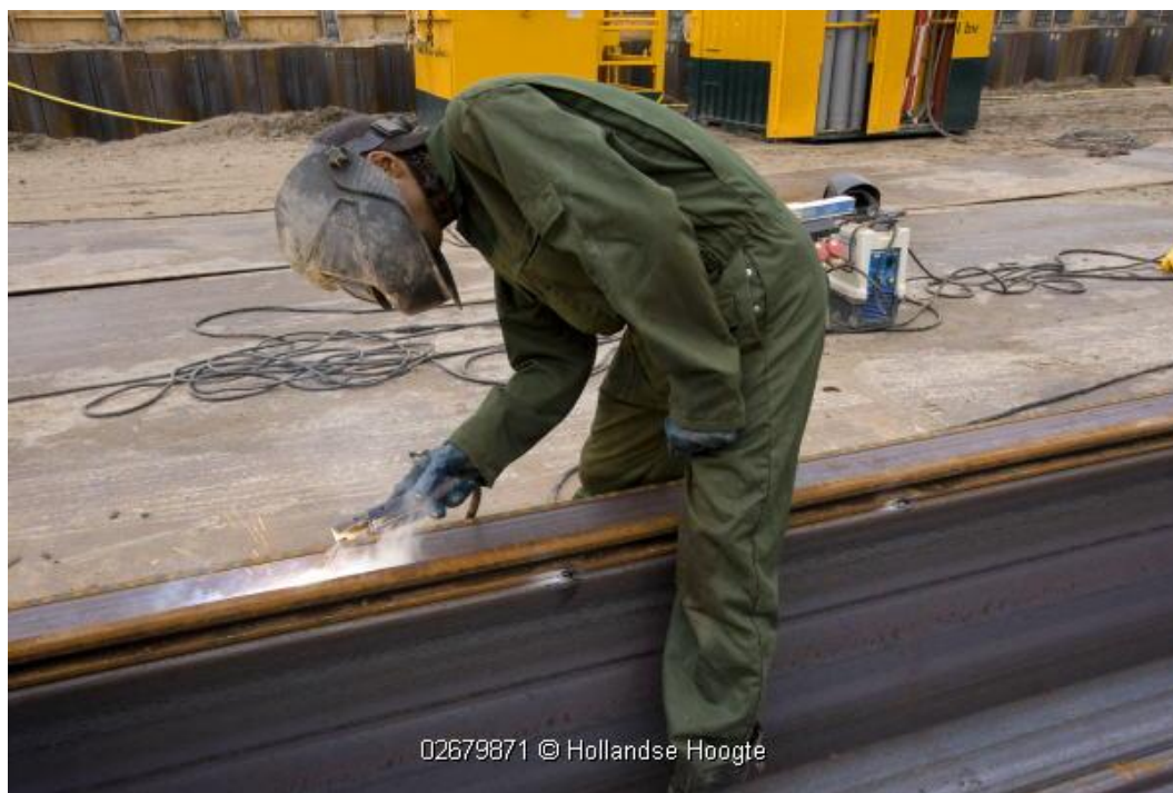
Een lasser prepareert een damwand op het Europaplein.
